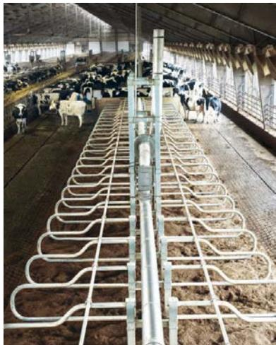
presenti. In particolare, il sistema prevede l'aspirazione localizzata dei gas tramite un tubo forato posizionato frontalmente alle vacche in cucetta, intercettando le emissioni direttamente alla fonte. Poiché l'anidride carbonica ( $\text{CO}_2$ ) e il metano ( $\text{CH}_4$ ) presenti in ambiente, vanno in competizione, per trattenere e catturare il metano servono due filtri distinti e specifici: un filtro che contiene un letto di zeolite che trattiene l'anidride carbonica; un filtro
