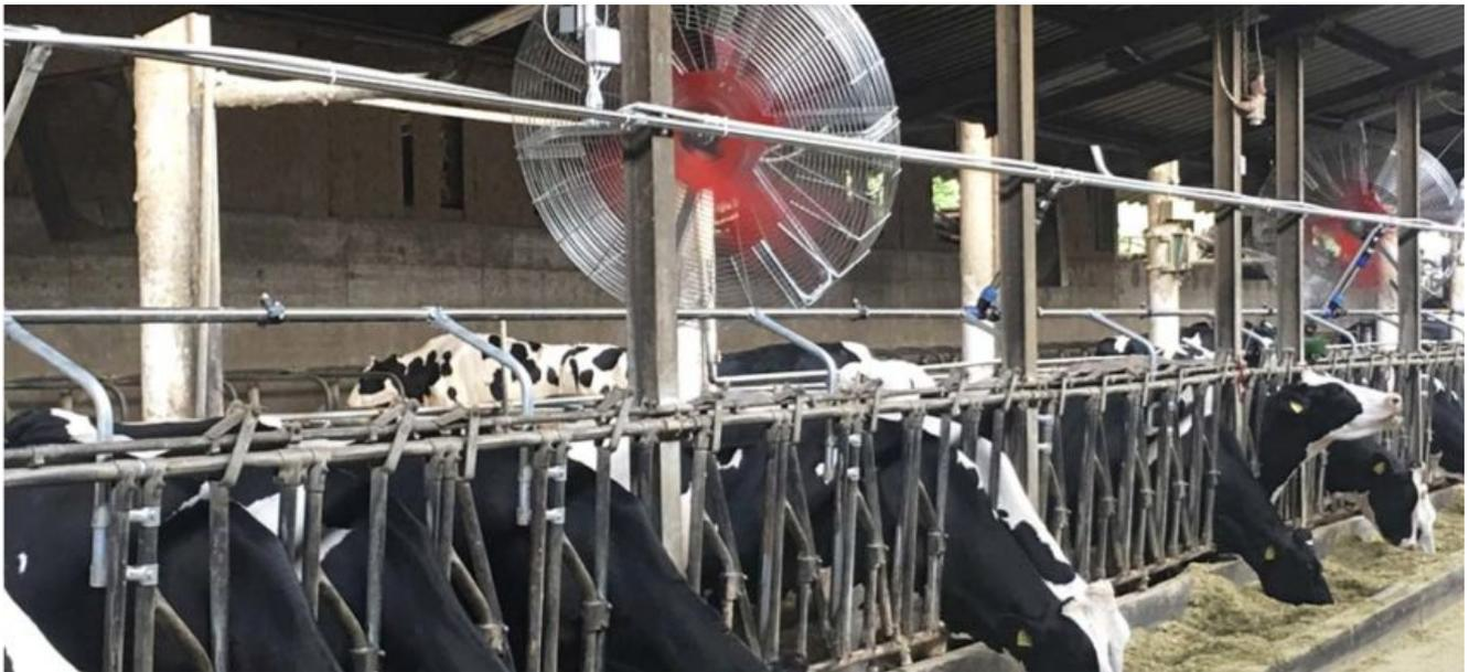
In inverno, l'**obiettivo** della ventilazione è **rimuovere il vapore acqueo** per contenere l'umidità e limitare i fenomeni di condensa. Condizione che si verifica quando le coperture non sono adeguatamente coibentate. È necessario assicurare un'**umidità inferiore all'80%**, valore che invece in alcune stalle della Pianura Padana raggiunge il 90%.
