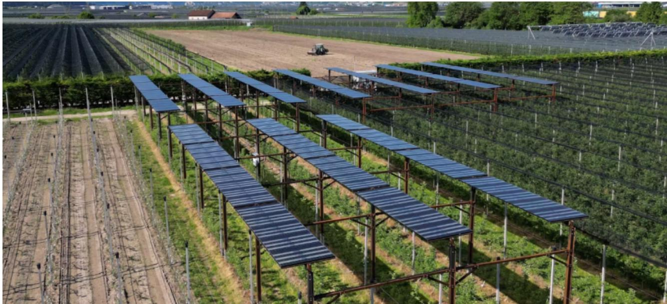
Il 26 maggio 2025 è stato inaugurato presso il maso Binnenland di Ora (Bolzano) il primo impianto agrivoltaico avanzato dell'Alto Adige. Su circa 3.000 m<sup>2</sup> di meleti della varietà Ipador/Giga® sono stati installati 200 moduli su strutture ad inseguimento solare (tracker). L'impianto ha una potenza di picco di 72,8 kWp e produce circa 95.000 kWh all'anno. Fa inoltre parte del progetto finanziato dall'UE «Horizon Symbiosyst» e coinvolge anche il Centro di
