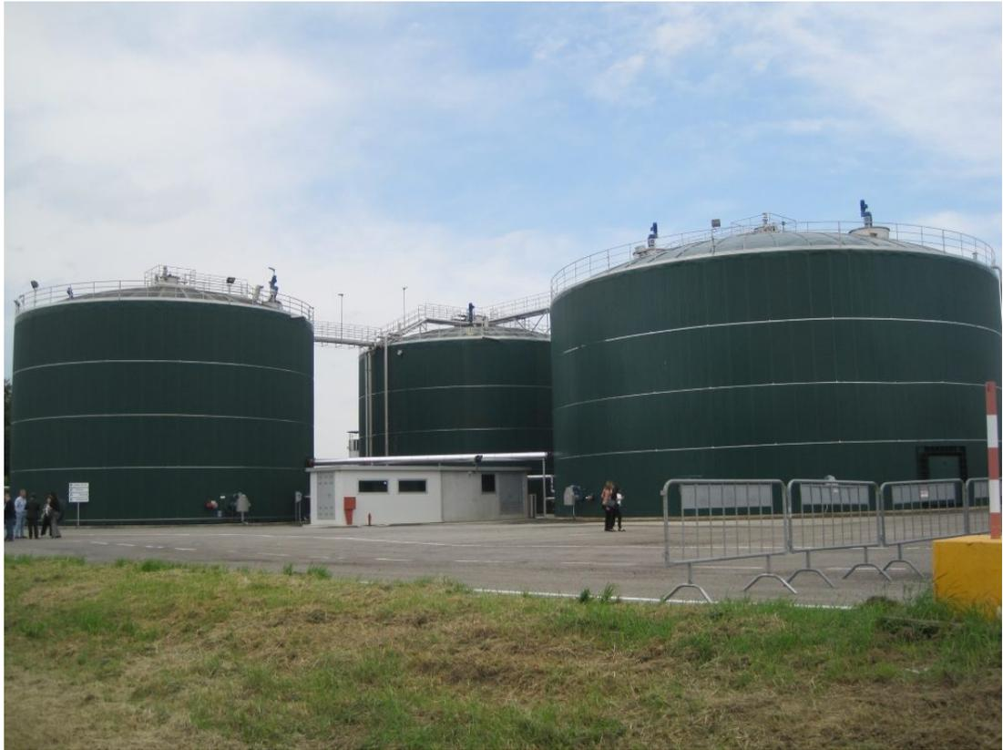
I grandi digestori inizialmente realizzati per la produzione di biogas e oggi convertiti per il biometano avanzato
