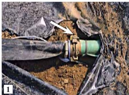
**1**-Per allacciare agevolmente le manichette ai tubi che portano l'acqua si possono impiegare gli appositi pratici attacchi (vedi freccia) che si trovano facilmente nei magazzini per l'idraulica, empori di materiale edilizio e centri per l'hobbistica. **2**-Volendo è possibile, tra la manichetta ed il tubo che porta l'acqua, inserire un rubinetto (vedi freccia) per regolare in maniera ancora più adeguata l'afflusso dell'acqua stessa
