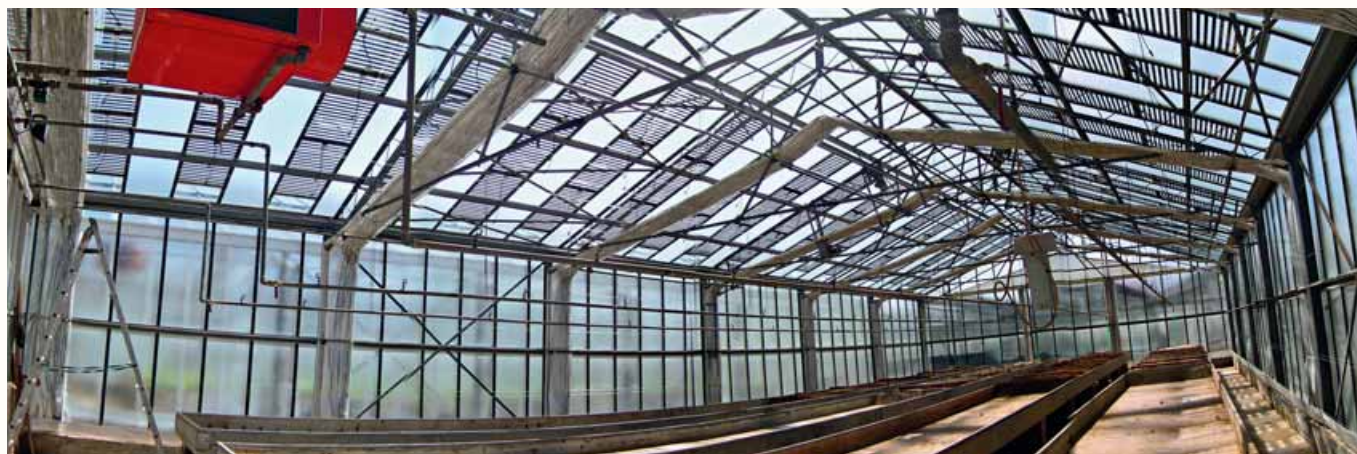
Foto A - Fase finale dell'installazione dell'impianto fotovoltaico di tipo CIS sulle falde della serra
