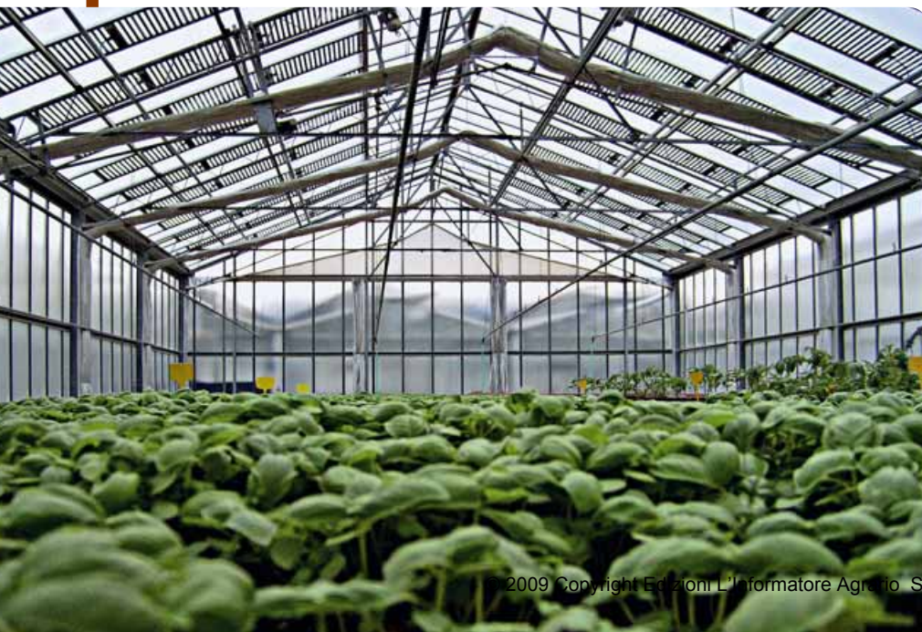
Foto 1 - Coltivazione di basilico nella serra fotovoltaica
